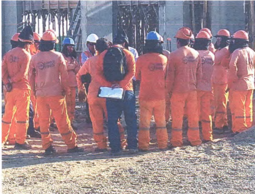
Foto 5: El Ing. De campo de la Obra realizando las indicaciones al personal antes de iniciar las tareas
