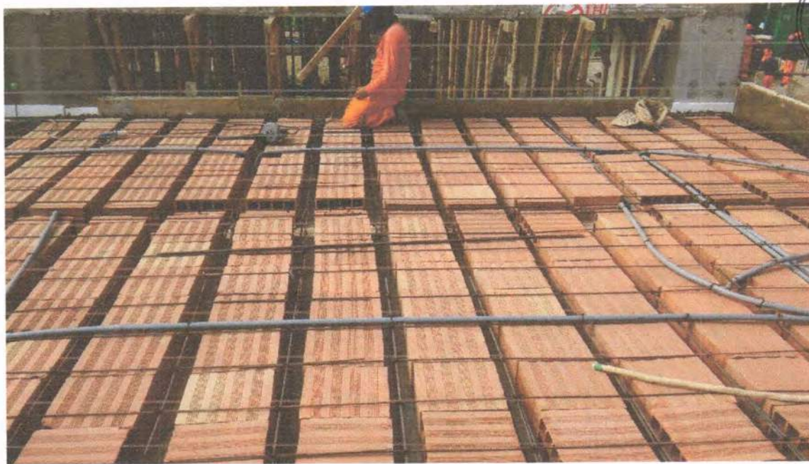
Colocación de tubería para salidas de luminarias.
