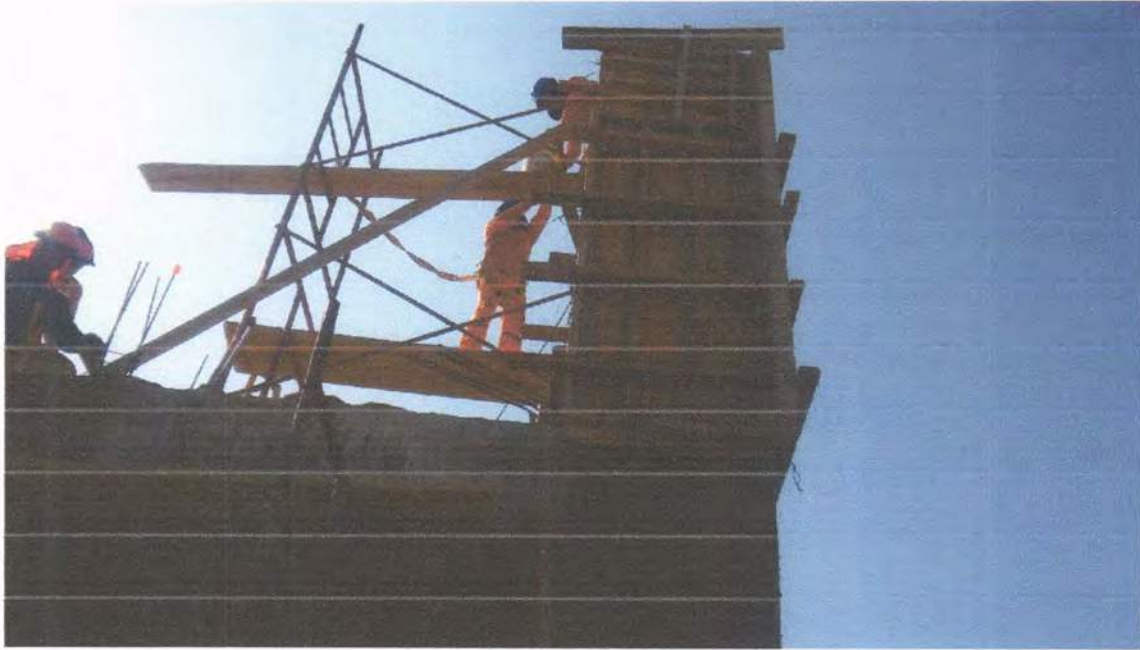
Vaciado de concreto en columnas
