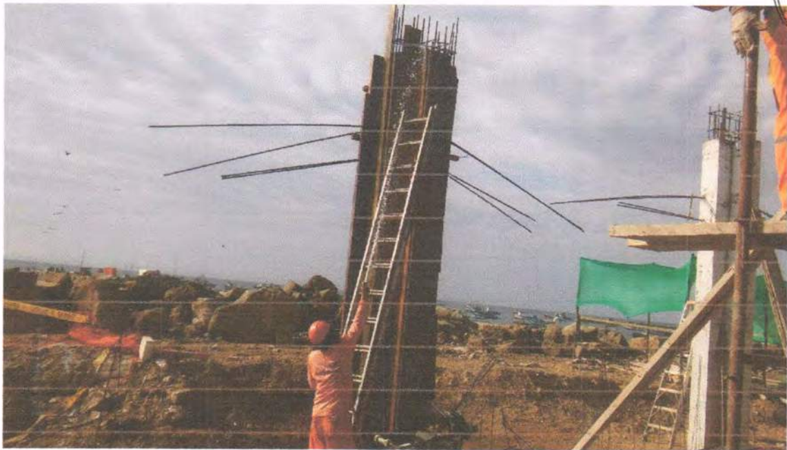
Encofrado de columnas.
