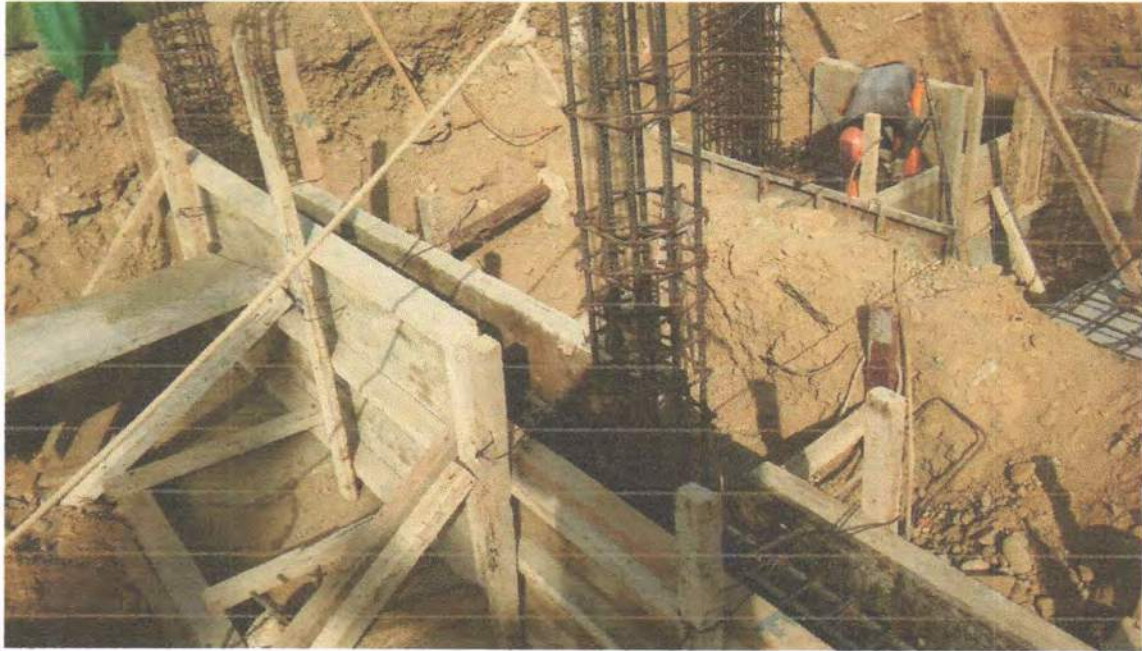
Encofrado de viga de cimentacion.
